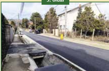
BEFEJEZŐDÖTT A MESSELIA-CSAPADÉKVÍZ ELVEZETÉSI PROJEKT
