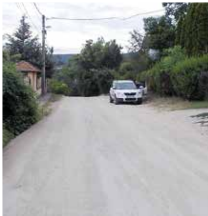
► Remix technológiával javították az útalapot az Eper utcában, a Mélyút utcában és a Cseresznyés utca felső szakaszán
