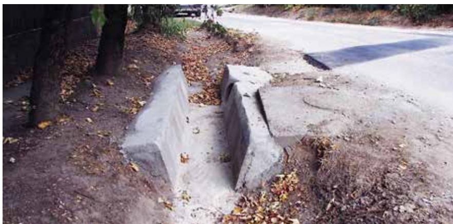
► Csapadékvíz-elvezetőt építettek az Ady Endre utca és a Mélyút utca kereszteződésében
